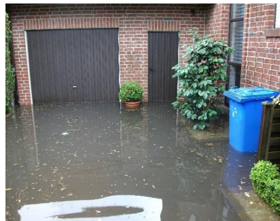
Abb. 6: Überflutete Einfahrten und Hauseingänge als häufigste Schadensursache in Olfen.
