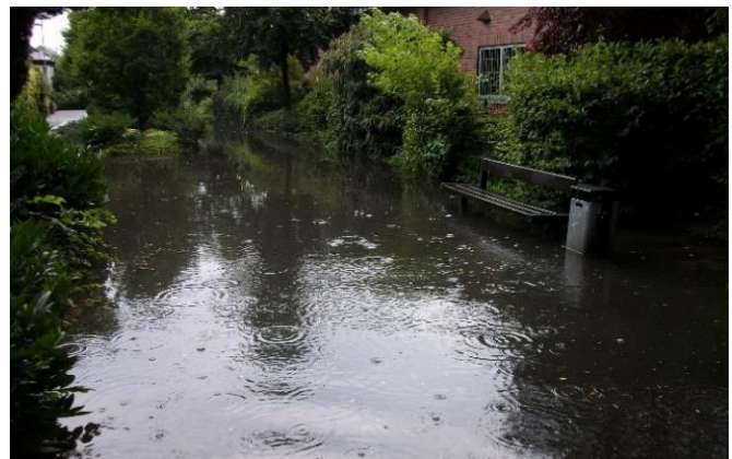
Abb. 2: Einstauung einer bedeutenden Fuß- und Radwegverbindung in Olfen infolge des Starkregenereignis am 20. Juni 2013.
