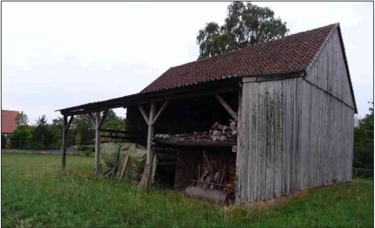
Abbildung 9: Scheune für Holz und Geräte im Südosten des Plangebiets (Süden).
